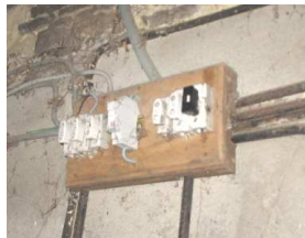
Exemples de tableau électrique et de chauffe-eau vétuste et dangereux et d'équipement sanitaire insuffisant
